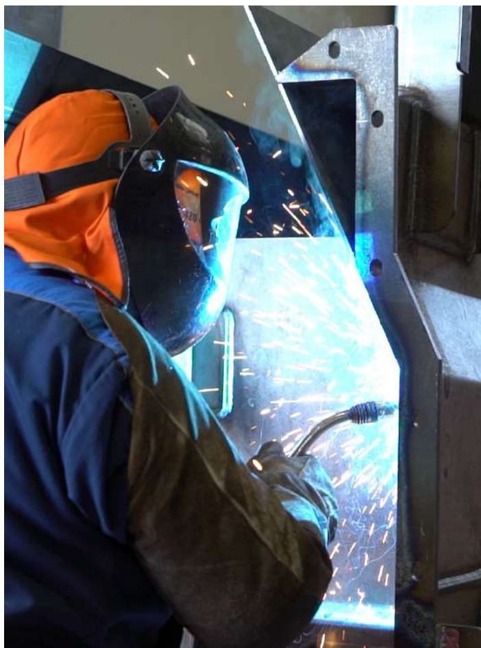
Soldadura componente planta de hormigón | Fuente: Autodesk
